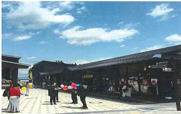
商業施設外観
